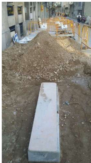
Tram inicial del Carrer de Septimània on finalitzaren les obres. A l'esquerra s'observa com es retira paviment d'asfalt UE 01. Al centre s'aprecia els nous embornals de formigó del clavegueram UE 07. A la dreta es veu la sola de formigó UE 02 a la vista després d'haver retirat el paviment d'asfalt que la cobria.
