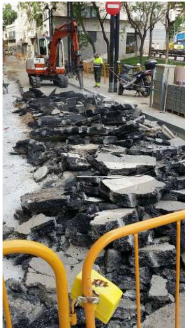
Tram inicial del Carrer de Septimània on finalitzaren les obres. A l'esquerra s'observa com es retira paviment d'asfalt UE 01. Al centre s'aprecia els nous embornals de formigó del clavegueram UE 07. A la dreta es veu la sola de formigó UE 02 a la vista després d'haver retirat el paviment d'asfalt que la cobria.
